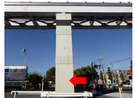
内部にコンクリートを詰めた鋼製支柱
