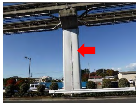
鋼板を巻いたコンクリート製の支柱
