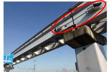
連結した軌道桁
