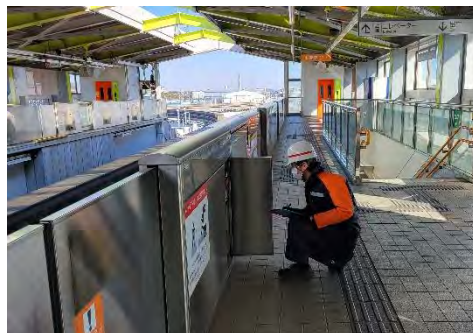
可動式安全柵の点検
